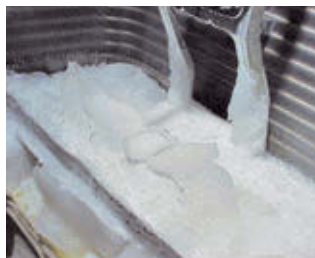
Jégképződés a tálcáfűtés nélküli kültéri egységen
